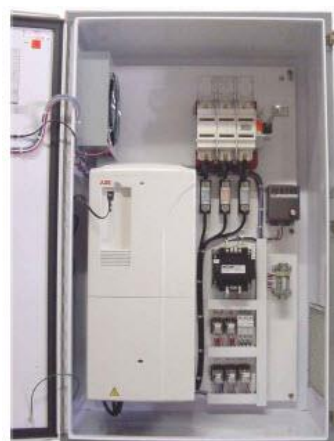
شکل ۶۳: تابلو کنترل موتور MCC، درایو و تابلو ایستاده کشویی
