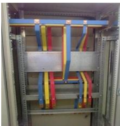
شکل ۶۷: شمش بندی تابلو برق
