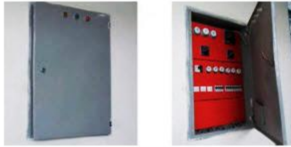
شکل ۶۵: تابلوی عمومی نصب شده در آپارتمان
