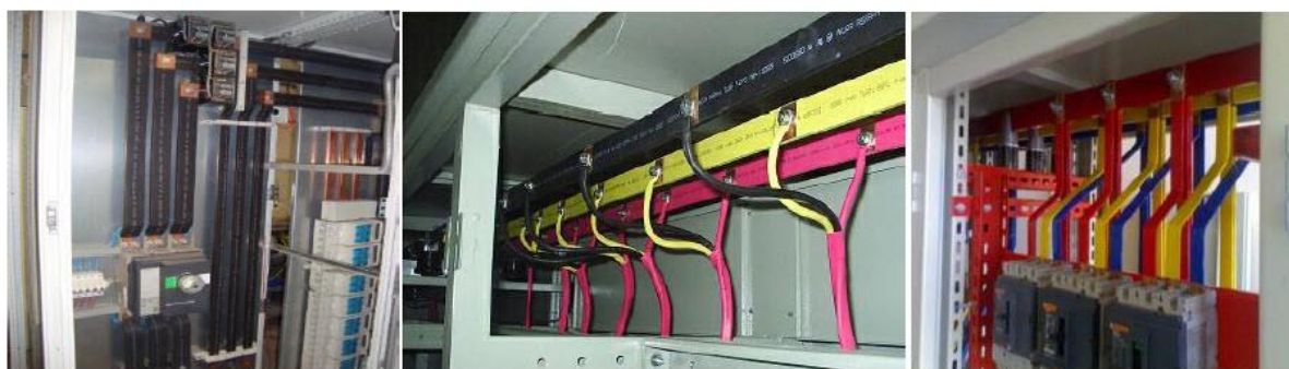
شکل ۲۲: چند مدل شینه متصل به تابلو
