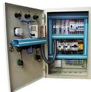
شکل ۶۲: تابلو کنترل موتوری MMC از نوع کشویی و تابلو دیواری
